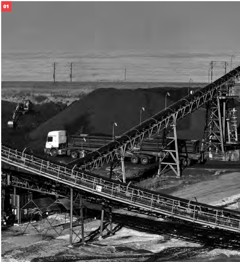
01 Mooiplaats stockpiles and beneficiation plant.
